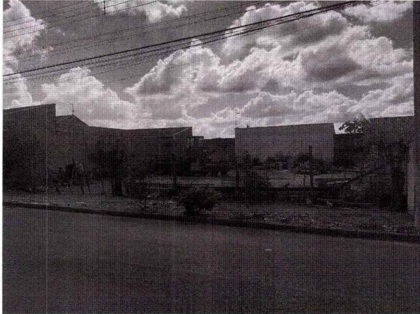
Foto 01 - Vista geral da área avalianda
