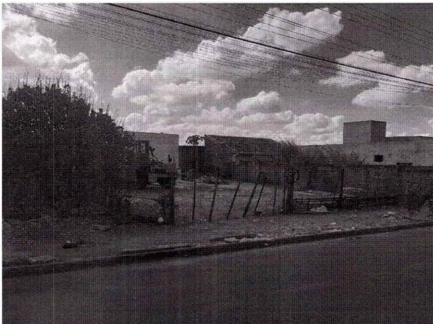
Foto 02 - Vista geral da área avalianda
